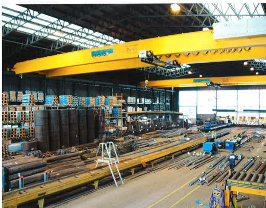
Der neue 2×4-Tonnen-Hallenkran im Vordergrund leistet bei der professionellen Kommissionierung von Bewehrungsstahl wertvolle Hilfe. (Bild: Gersag)
