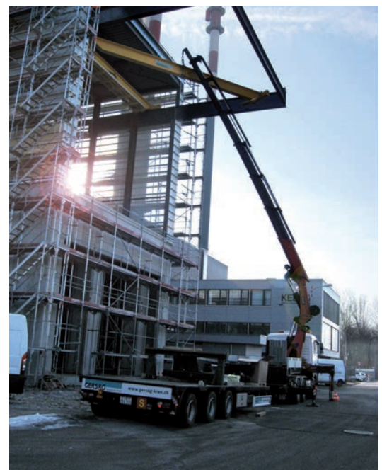
Montage der zweiten Kranbrücke
