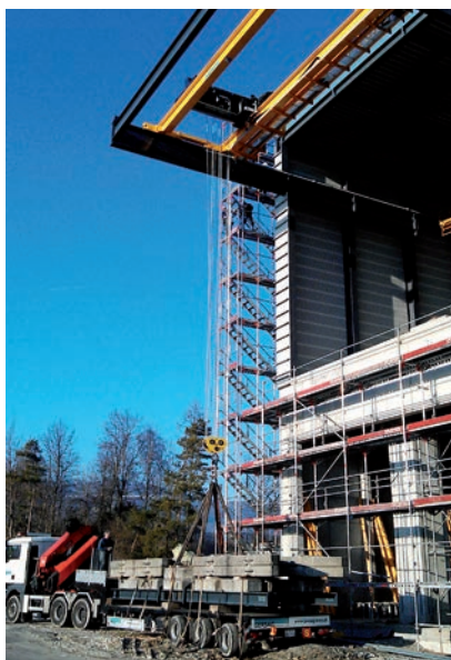
Lastabnahme mit Prüfgewichten
