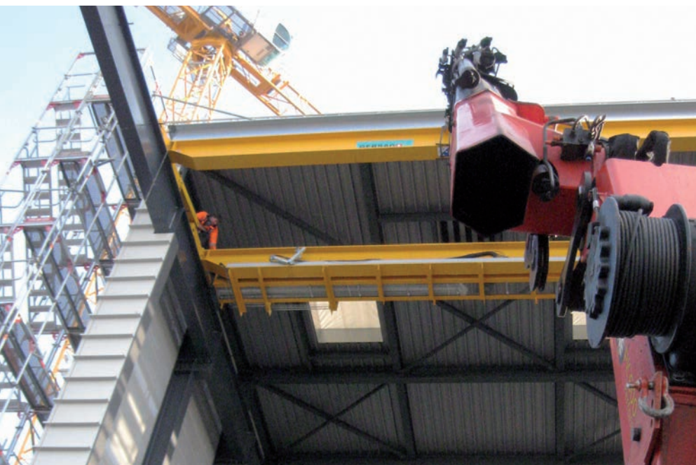
Montage des Verbindungsstücks der Boogy-Fahrwerke aus Sicht des LKW-Kranführers
