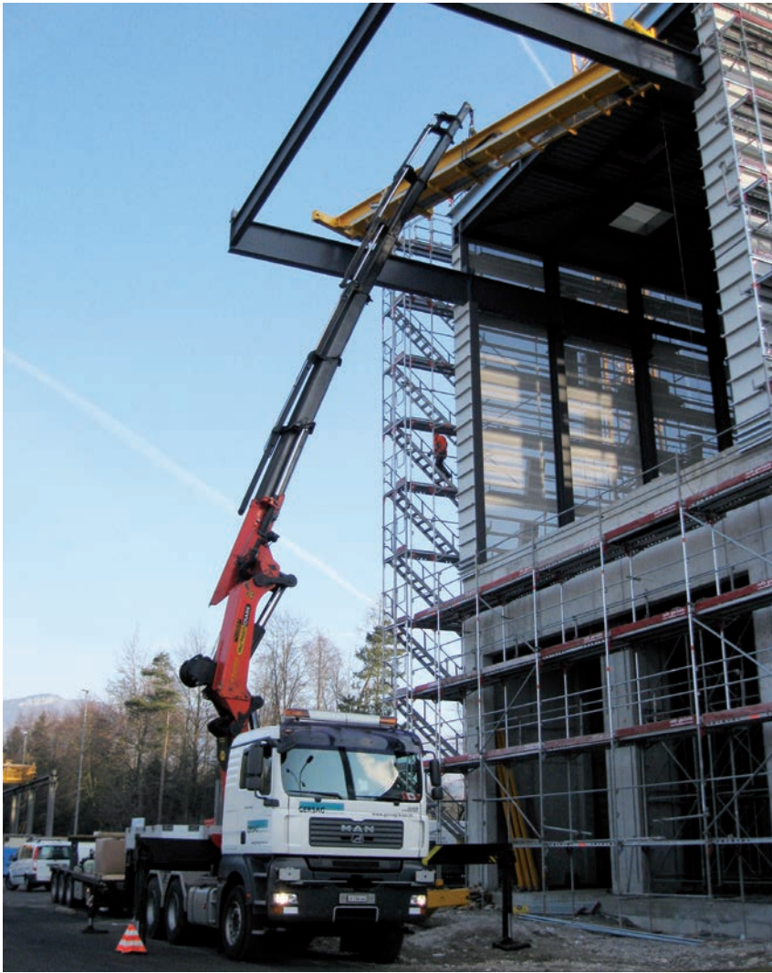
Montage der ersten Kranbrücke
