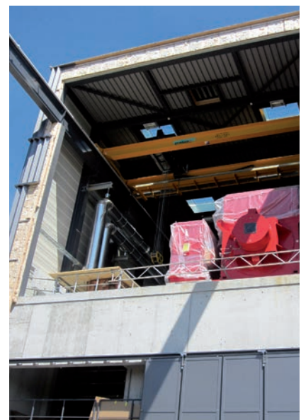
Hallenöffnung zum Einbringen der Maschinenkomponenten
