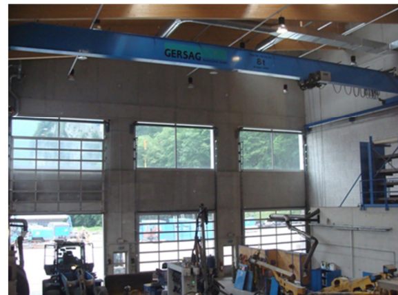
Werkhof der Gasser Felstechnik AG in Lungern mit dem 8t Hallenkran in mit blauem Anstrich.
