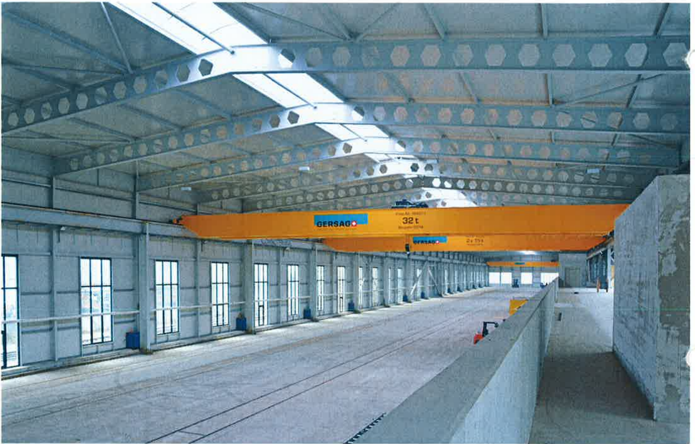
Hallenansicht von innen mit Oblichtband Binder aus Wabenträger
