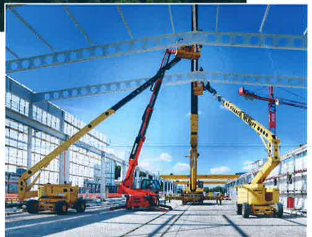
Pneukrane & Hebebühnen für Montage
