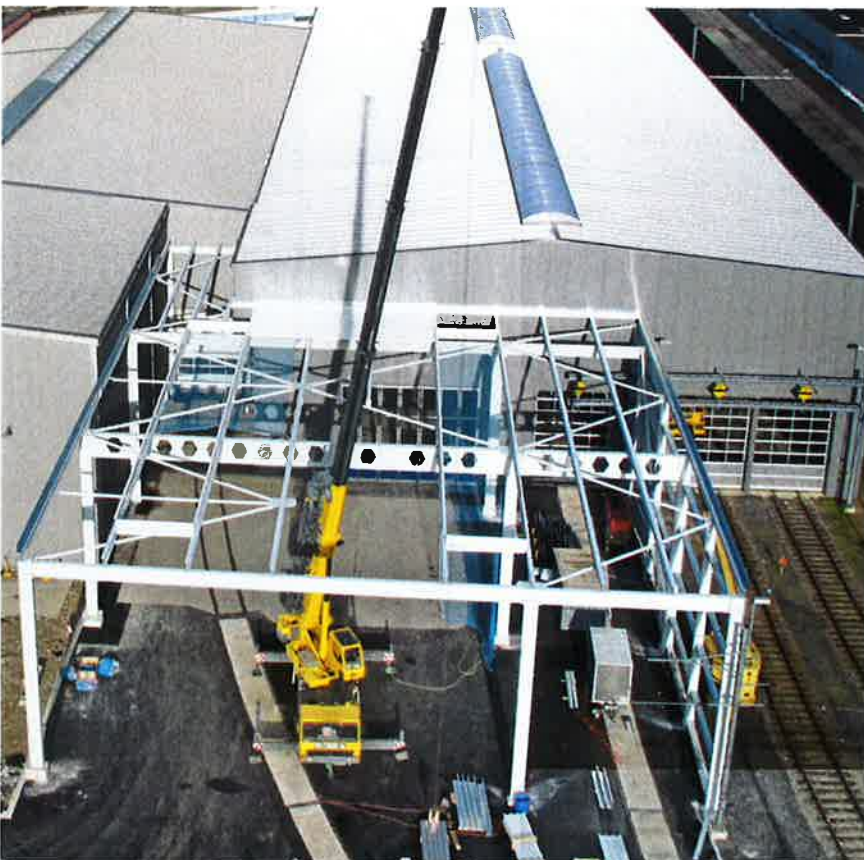
Vordach für Bahnverlad mit 2 Oblichtbändern
