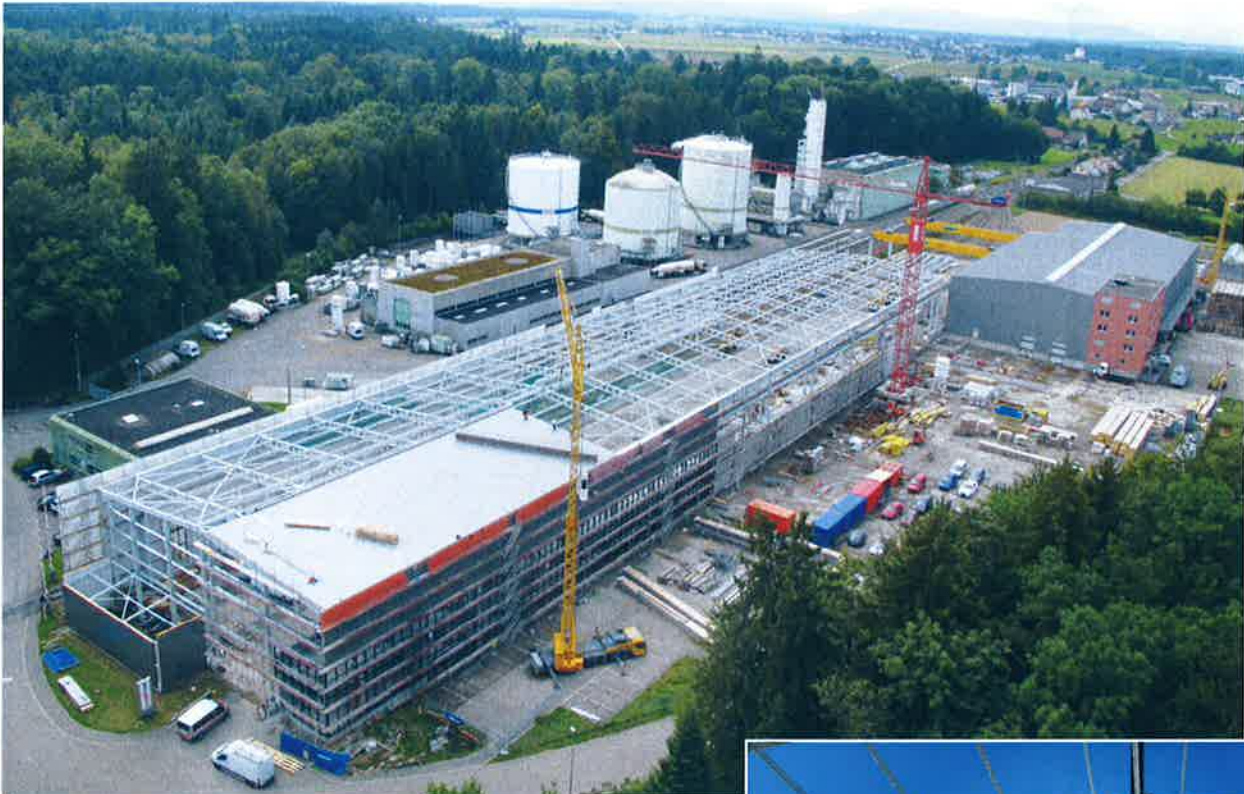
Stahlmontage mit nachlaufender Dach- und Fassadenverkleidung
