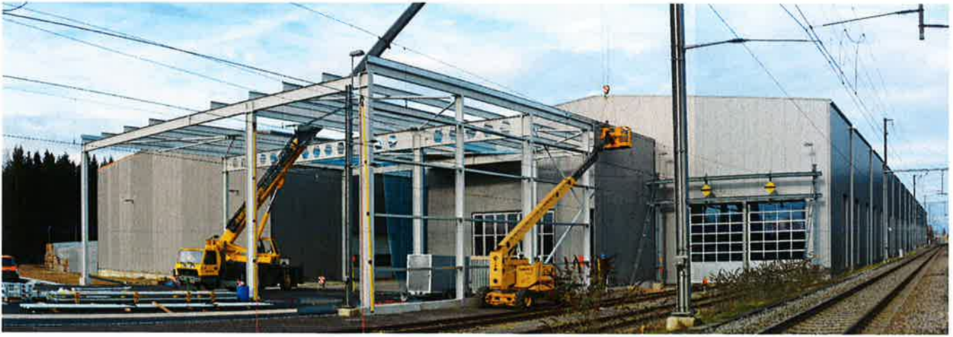
Fassadenblechmontage neben Bahnanlage
