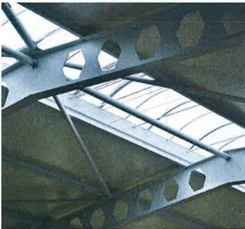
Oblichtband im First
