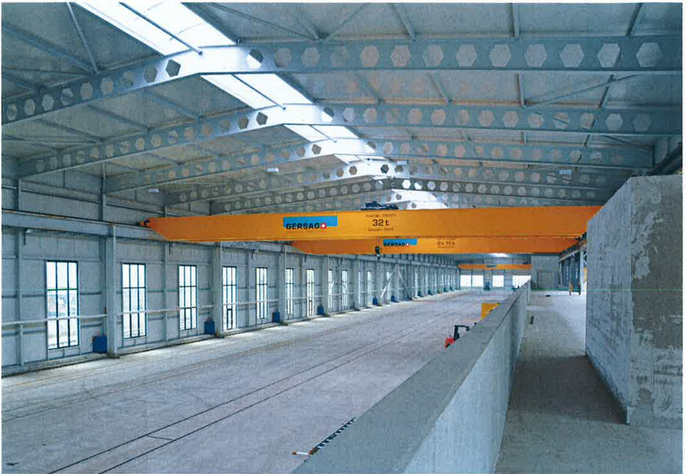
Haupthalle von innen mit Oblichtband Binder aus Wabenträger
